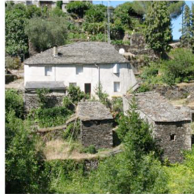
Lespinassière : lauzes sur habitation et sur annexes.
