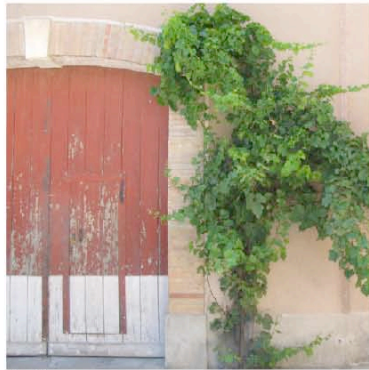
Azille : effet de soubassement, badigeon rosé sur enduit, répondent à la brique de l'encadrement, au rouge sang de la porte du chais.
