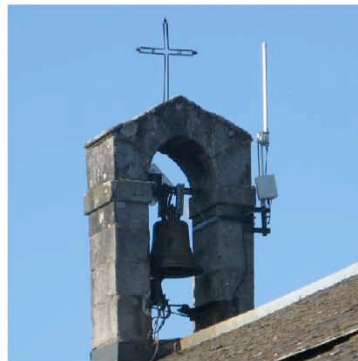
Laprade : installation d'antenne
