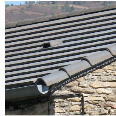
Castans hameau de Lavielle tuiles béton plates et noires
