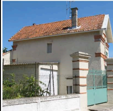
La Redorte, maison de l'entre deux guerre. La tuile de Marseille est cohérente avec cette architecture
