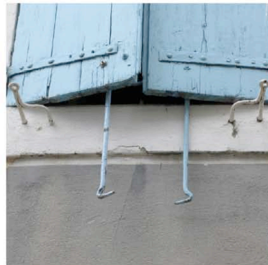
Aigues Vives dispositif de blocage de contrevent
