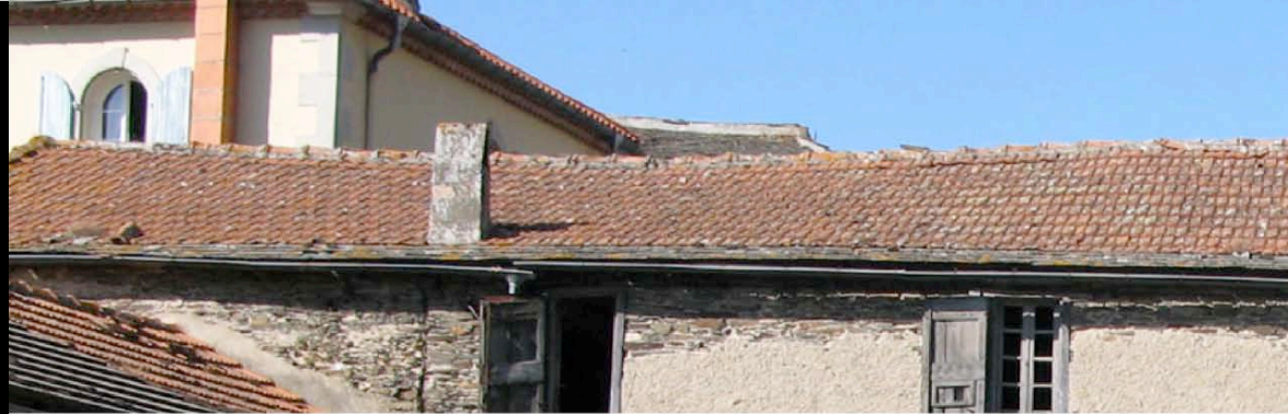
Caudebronde la tuile mécanique plate dite de Marseille s'adapte aux pentes des versants couverts de tuiles canal ou de lauze, qu'elle a pu remplacer.
