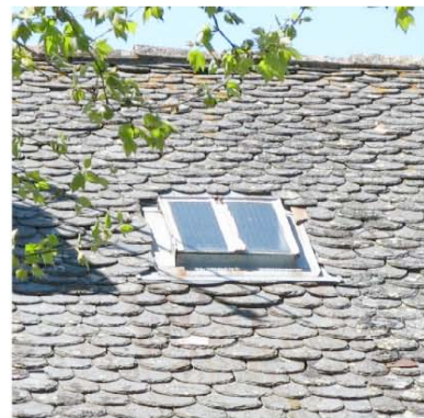
Saint-Denis fenêtre de toit type «trou d'homme» pour faciliter l'accès à la toiture
