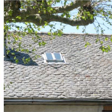
Saint Denis : toiture en ardoise épaisse travaillée en écaille de poisson.
