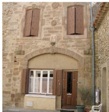
Pépieux : recomposition d'ouvertures à l'intérieur de cet encadrement ancien.
