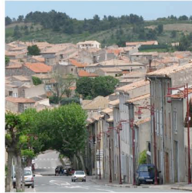
Caunes Minervois : vue depuis l'accès ouest, importance des toitures de tuiles canal...
