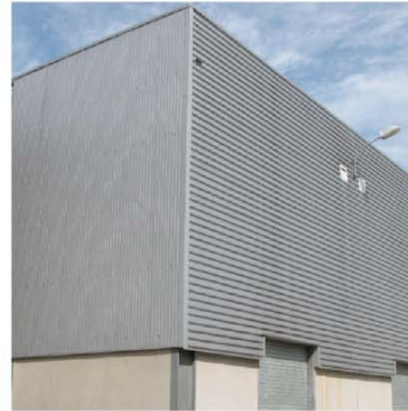
Rieux Minervois bardage métallique sur un des bâtiments récents de la cave coopérative
