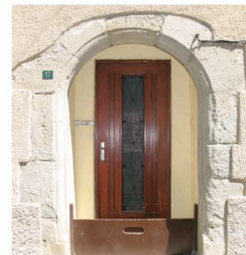
Rieux Minervois : mise en retrait et reposition d'ouverture de porte derrière cet encadrement daté du XVI e siècle.
