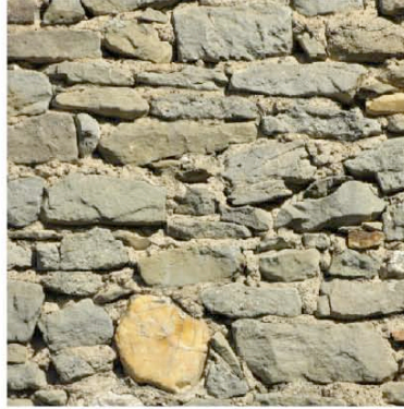
Bagnoles : lit de grés plutôt grise avec insertion de pierre d'une autre nature (récupération ou réemploi?)
