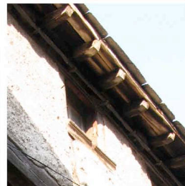
Mas Cabardés débord de toit (rare) en bois, ici lié à un édifice à structure bois.
