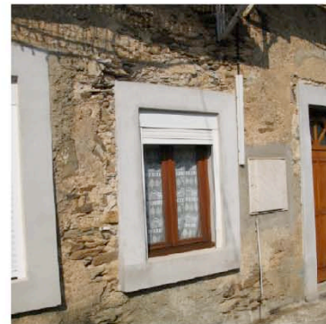
ournes Cabardés : reprise ou création d'ouverture : encadrement, menuiseries, volets roulants...
