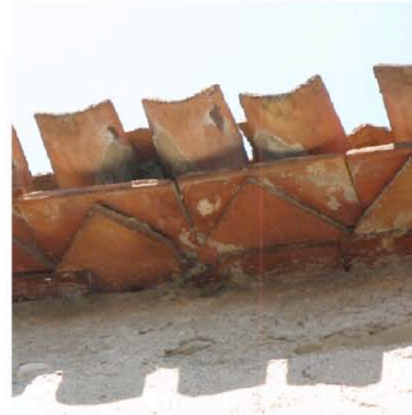
Peyriac Minervois génoise avec carreaux de terre cuite
