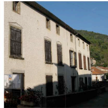
Mas Cabardès construction de 1663.
