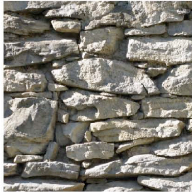
Malves : assemblage de pierre calcaire
