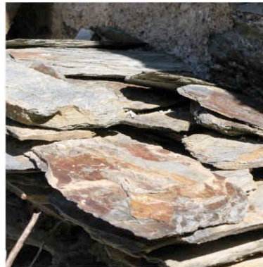
Cabrespine lauze, élément déposé toiture en réfection
