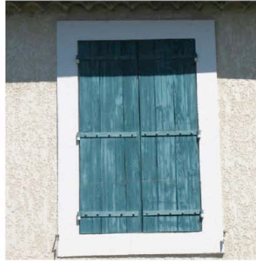
Montclar : façon d'encadrement et contrevents de planches étroites.
