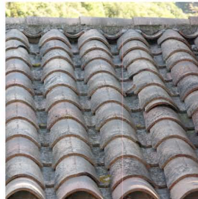
Roquefère tuiles canal de terre cuite «neuves»
