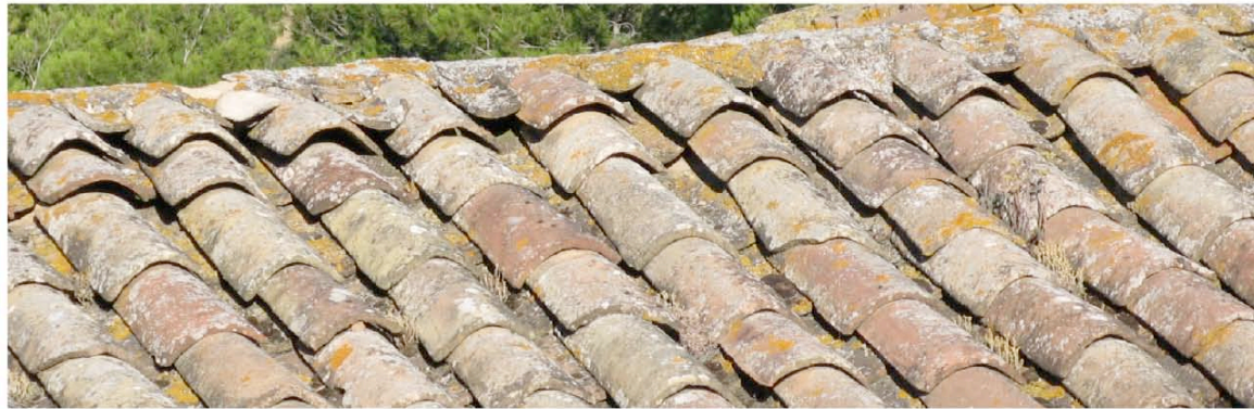
Bouilhonnac : le format des tuiles canal, leur pose, la charpente, permettent d'absorber dans le temps quelques déformations.
