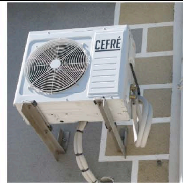
Puichéric : les apports d'équipements «bruts» en façade
