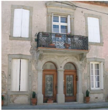
Saint Couat : reprise d'ouvertures en rez de chaussée et changements des menuiseries de portes et de fenêtres
