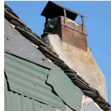
Laprade sur le corps de cheminée originel et maçonné, un système qui permet une réduction, et une protection de l'âtre.
