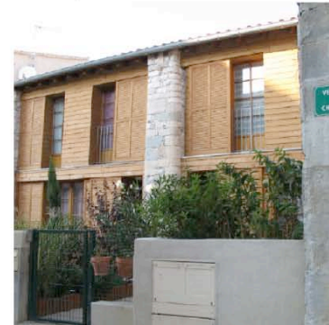
Ventenac Cabardès : maisons mitoyennes contemporaines, en bois au pied du château, alignées sur un mur et ouvertes sur un passage
