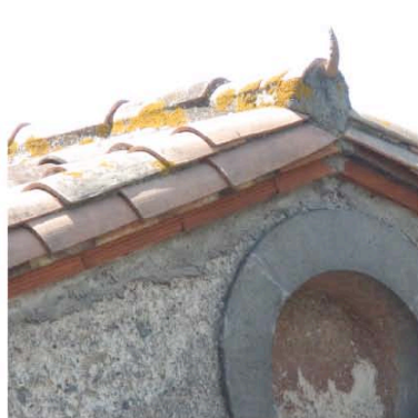
Conques sur Orbiel détail de rive et de faitage
