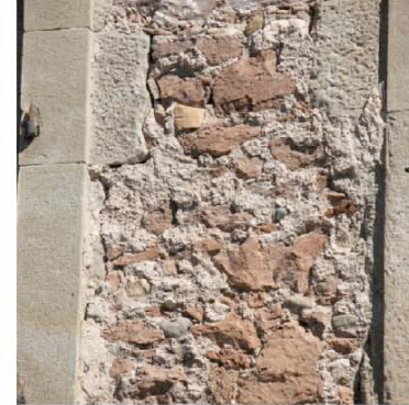
Puichéric : la manière dont est taillé l'encadrement, témoigne de la prise en compte de l'épaisseur des enduits
