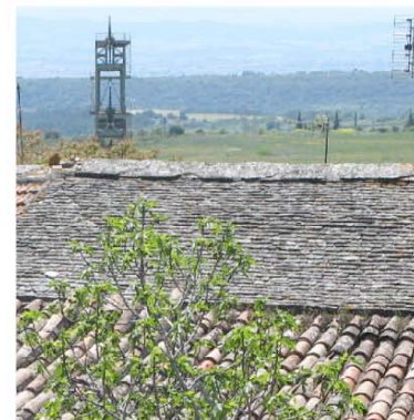
Villanière : les pentes des versants sont les mêmes pour les lauzes et la tuile canal...incitant au remplacement progressif.
