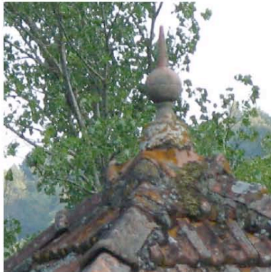
Miraval, Le Rougé cépi de faitage en terre cuite, propre à des décors du début du XX e siècle ou de la toute fin XIX e
