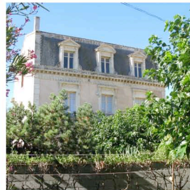
Marseillette :combles à la Mansard.
