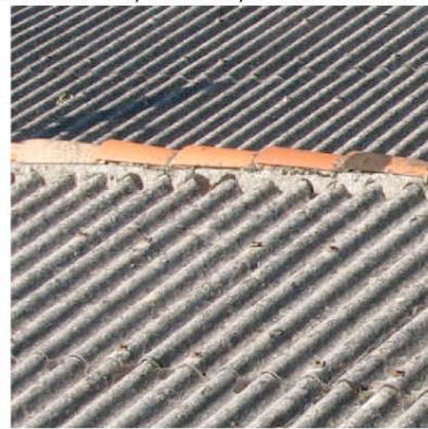
Labastide Esparbairénque tôle ondulée en fibro ciment sur constructions dans le village
