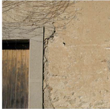
Bouilhonnac couleur chaude des enduits réalisés à la chaux et aux sables locaux
