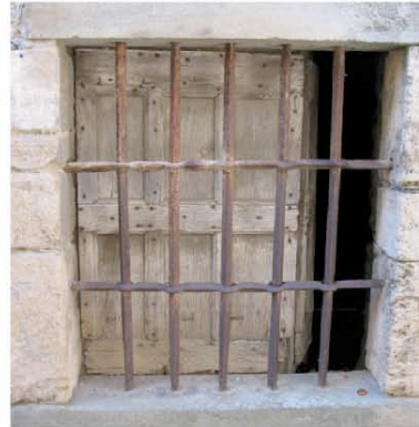
Les Ilhes Cabardès barreaudage et volet intérieur, fenêtre de demi-sous-sol.
