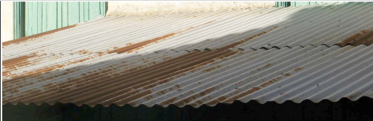
Labastide Esparbairénque couverture en tôle métallique d'un apprentis
