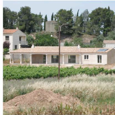
Moux : maison de construction récente à l'entrée ouest de Moux
