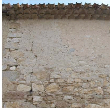
Floure : qu'il s'agisse d'habitations ou de chais les murs sont protégés par des enduits
