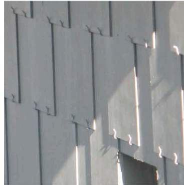
Laprade : bardage de plaque de ciment
