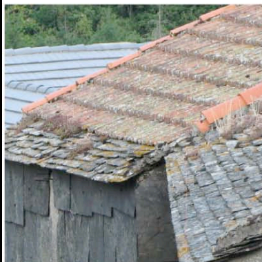
La Tourette Cabardés : tuiles mécaniques et lauzes
