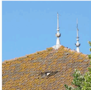
Marseillette épi de faitage en zinc et toiture en tuiles mécaniques de terre cuite
