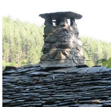
Castans forme de cheminée avec toiture en lauze
