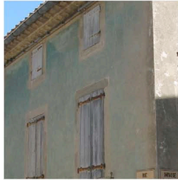
La Redorte : colorant vert pour le badigeon de la façade principale de cette maison.
