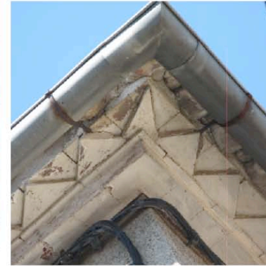
Rieux Minervois traitement d'angle urbain à base de carreaux de terre cuite, badigeonnée de chaux et formant décor de corniche.
