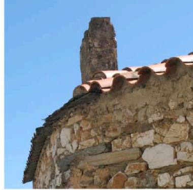
Trassanel forme de cheminée avec toiture tuiles canal et tôle
