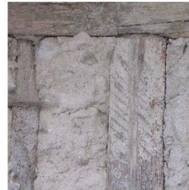
Villeneuve les Montréal : maison ossature bois, entre les colombages : remplissage en pisé (terre crue et fibres végétales).
