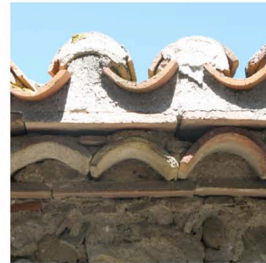
Montclar tuiles de doublis sur la sablière
