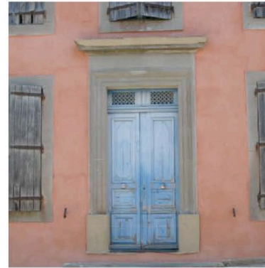
Villazel porte à deux battants avec imposte, typique du XIX e siècle
