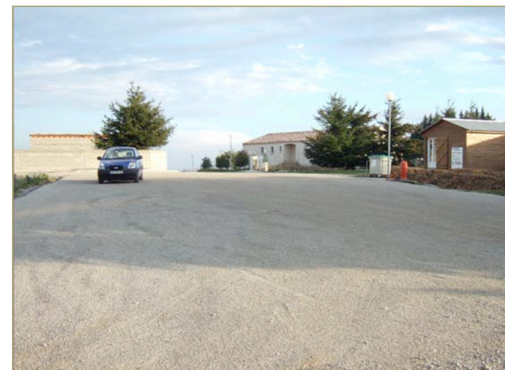
La voirie interne et le parking de la zone
