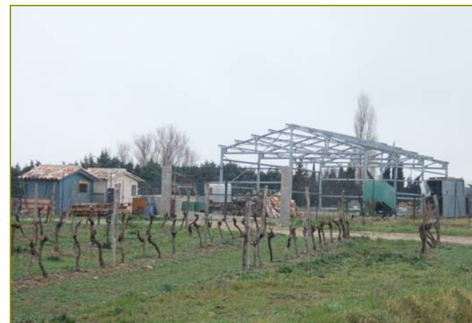
Les locaux de l'artisan maçon en cours de construction
