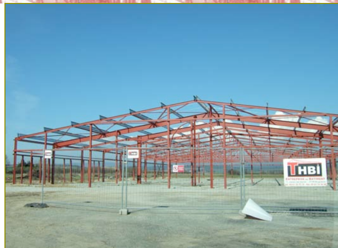
La charcuterie en construction
