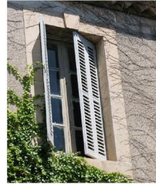
Saint Couat volet persienné repliable en tableau, encadrement pierre
