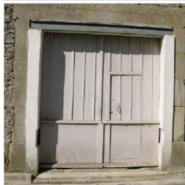
Bagnoles porte de chais à couvre joint
