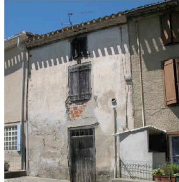
Alairac : trame étroite, habitat modeste, remise au rez de chaussée, pièce d'habitation à l'étage et grenier sous les combles
