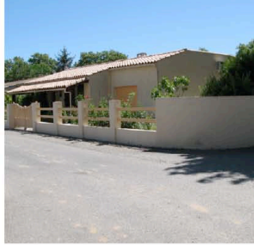
Saint-Couat : maison de construction récente
