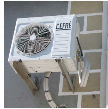
Puichéric : les apports d'équipements «bruts» en façade
