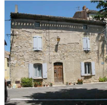
Trausse, à côté du domaine. Les menuiseries de porte, les arcs des ouvertures de fenêtre, la date au linteau de la porte témoignent de la date de construction.
