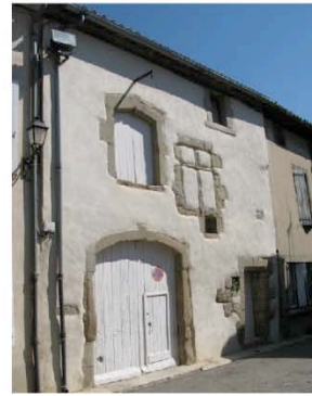
Rieux Minervois reprise d'enduit de façade dont l'épaisseur et les finitions amoindrissent la qualité des détails préservés.
