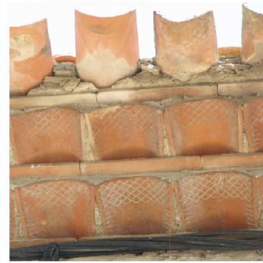
Saint Couat 2 rangs de tuiles de confection plus récente, elles portent une façon d'entaille qui les distinguent.
