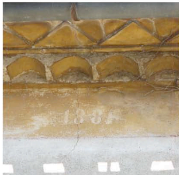
Azille : les badigeons de nombreuses façades portent les dates de leur réfection ici 1881. Les ocres sont d'origine locale.
