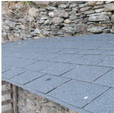
Mas Cabardés bardeau bitumé ou shingle pour cet auvent rapporté sur une porte d'entrée.
