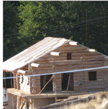
Lacombe : murs en rondins de bois pour cette maison en cours de chantier
