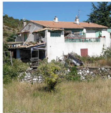
Trassanel : maison en perpétuels travaux
