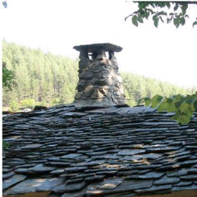
Castans : ferme des «lamas» couverture de lauze.
