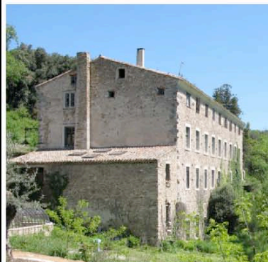
Broussès et Villaret : ancienne usine de trituration de tissu. L'eau façonne aussi les activités.
