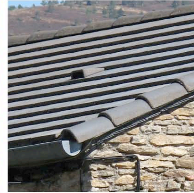
Castans hameau de Lavialle tuiles béton plates et noires
