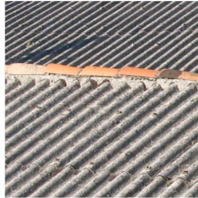
Labastide Esparbairènegue tôle ondulée en fibro ciment sur constructions dans le village
