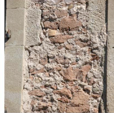
Puichéric : la manière dont est taillé l'encadrement, témoigne de la prise en compte de l'épaisseur des enduits
