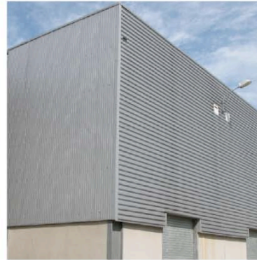
Rieux Minervois bardage métallique sur un des bâtiments récents de la cave coopérative
