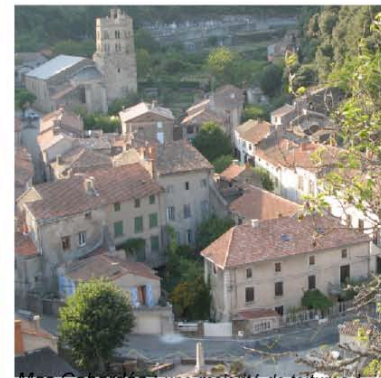
Mas Cabardès : une majorité de toitures à deux versants dans le barry, sur la départementale un édifice avec ses quatre versants tient compte de la situation urbaine.
