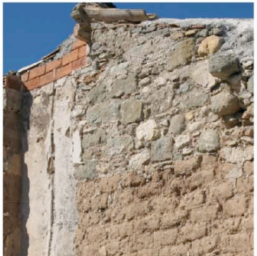
Marseillette mur mitoyen laissant voir les différents matériaux de construction : grés, calcaires, et terre crue
