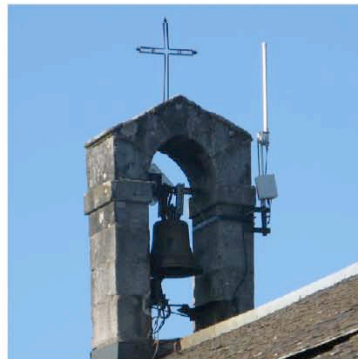
Laprade : installation d'antenne
