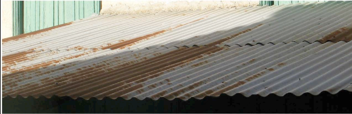
Labastide Esparbairènegue couverture en tôle métallique d'un appentis
