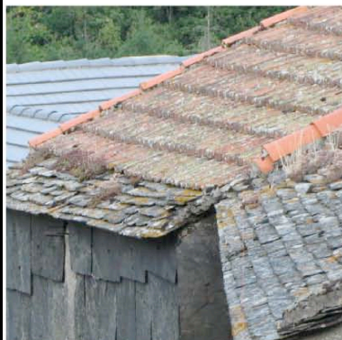
La Tourette Cabardés : tuiles mécaniques et lauzes
