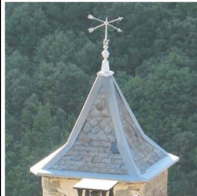
Labastide Esparbairènegue docheton d'une maison XIX e avec façonnage décoratif de l'ardoise
