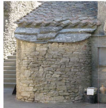
Villarzel couverture du four en lauze de pierre calcaire.
