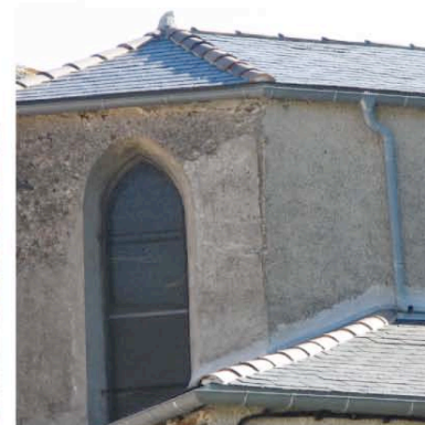
Roquefère couverture de l'église paroissiale
