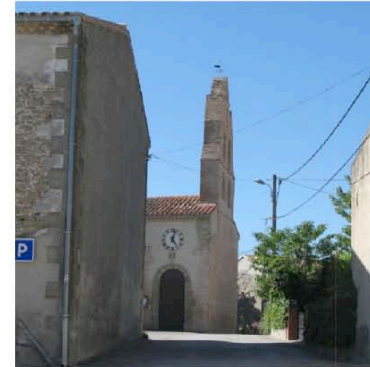
Villeneuve les Montréal : clocher mur de l'église
