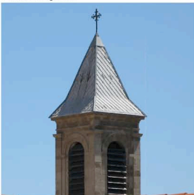
La Redorte église et clocher XIX e , avec un façonnage particulier des ardoises en losanges.
