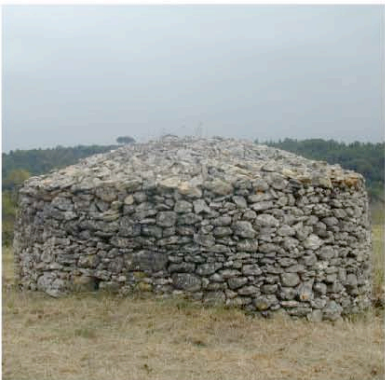
Montolieu : couverture de lauze de pierres calcaire pour les capelles.
