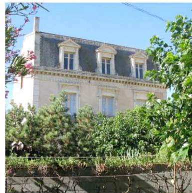
Marseillette :combles à la Mansard.
