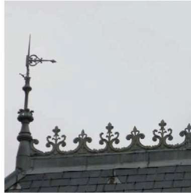
Moussoulens épi de faitage en zinguerie sur toiture ardoise de domaine XIX e
