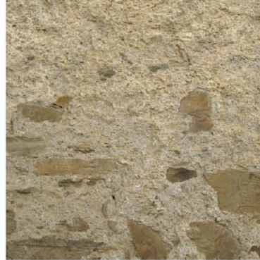
Labastide Esparbairènegue : enduit à fleur résultant du lessivage de l'enduit par les intempéries.
