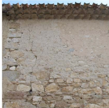
Floure : qu'il s'agisse d'habitations ou de chais les murs sont protégés par des enduits
