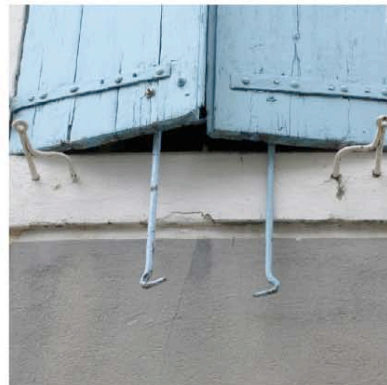
Aigues Vives dispositif de blocage de contrevent
