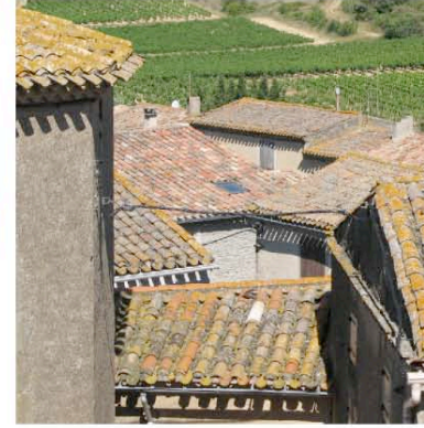
Villazel : depuis l'escalier de la tour, imbrication des volumes de toiture...
