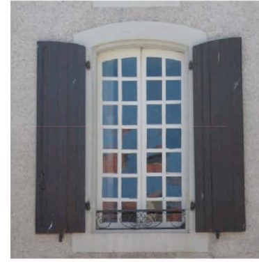
Arzens : fenêtre XVIII° à petits carreaux et à linteau courbe, encadrement de pierre.
