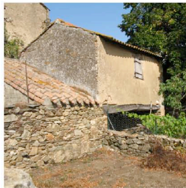
Fournes : toit à deux versants pour cette annexe à cheval entre rue et jardin, toit à un versant pour l'appentis
