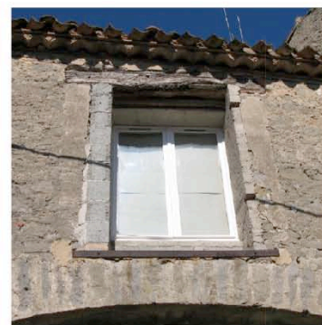
Marseillette reprise et modification d'ouverture et remplacement de menuiserie
