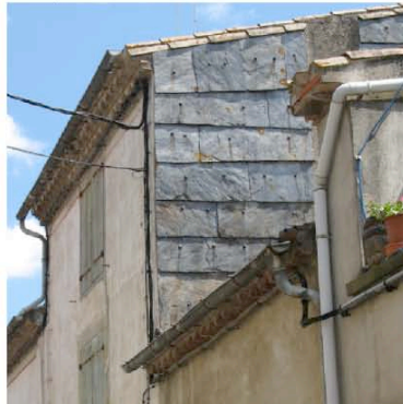
Villegailhenc : le bardage de lauzes peut s'installer en pignon comme ici, ou en façade principale, selon l'orientation à la pluie et aux vents dominants.
