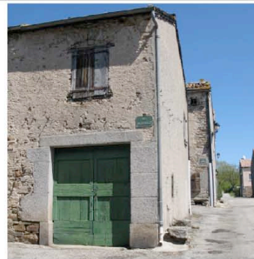
Saint Denis : menuiseries peintes pour cette porte d'annexe
