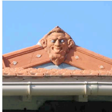
Les Martyrs : architecture de «pavillon» et décor de rive accompagnant la toiture de tuiles mécaniques
