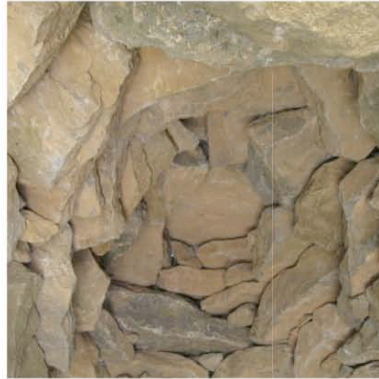
Badens mise en oeuvre des lauzes calcaire vue de l'intérieur d'une capitelle
