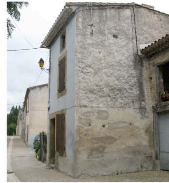
Sainte Eulalie maison à une travée
