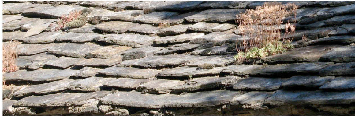
Castans : un bel exemple de toit en lauzes, grandes dalles en rive près des murs, dalles de format plus petit pour le reste de la couverture.
