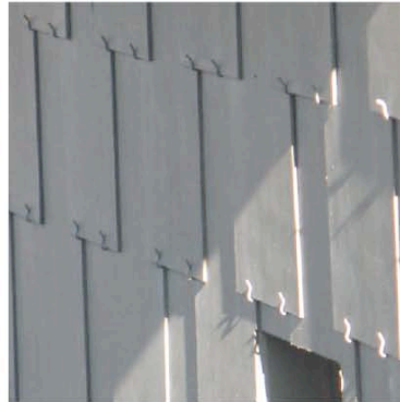
Laprade : bardage de plaque de ciment
