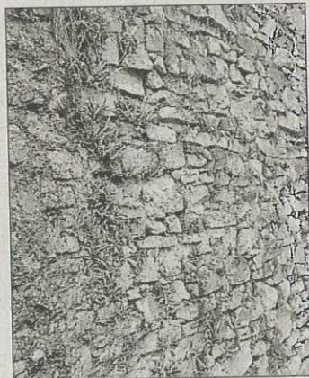
► Le mur de soutien du parking du Bosquet présente des endroits de faiblesse. Une mise en sécurité s'impose.
