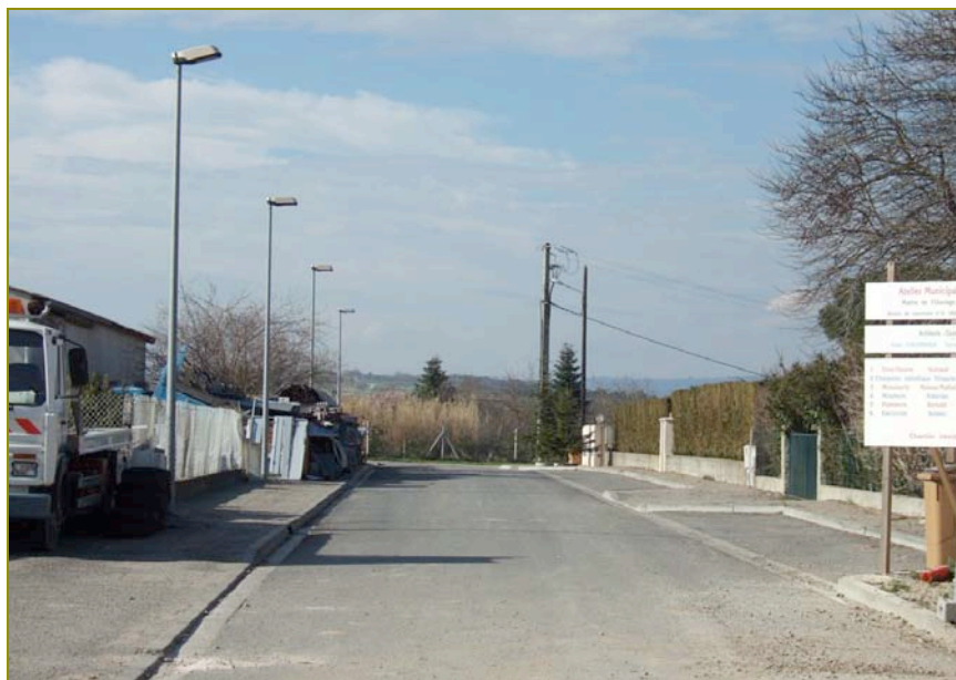
Utilisation des trottoirs comme aire de stockage de matériaux
