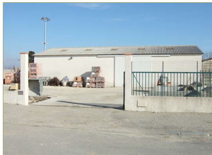
L'entreprise de maçonnerie
