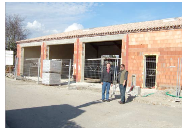
L'atelier municipal en construction
